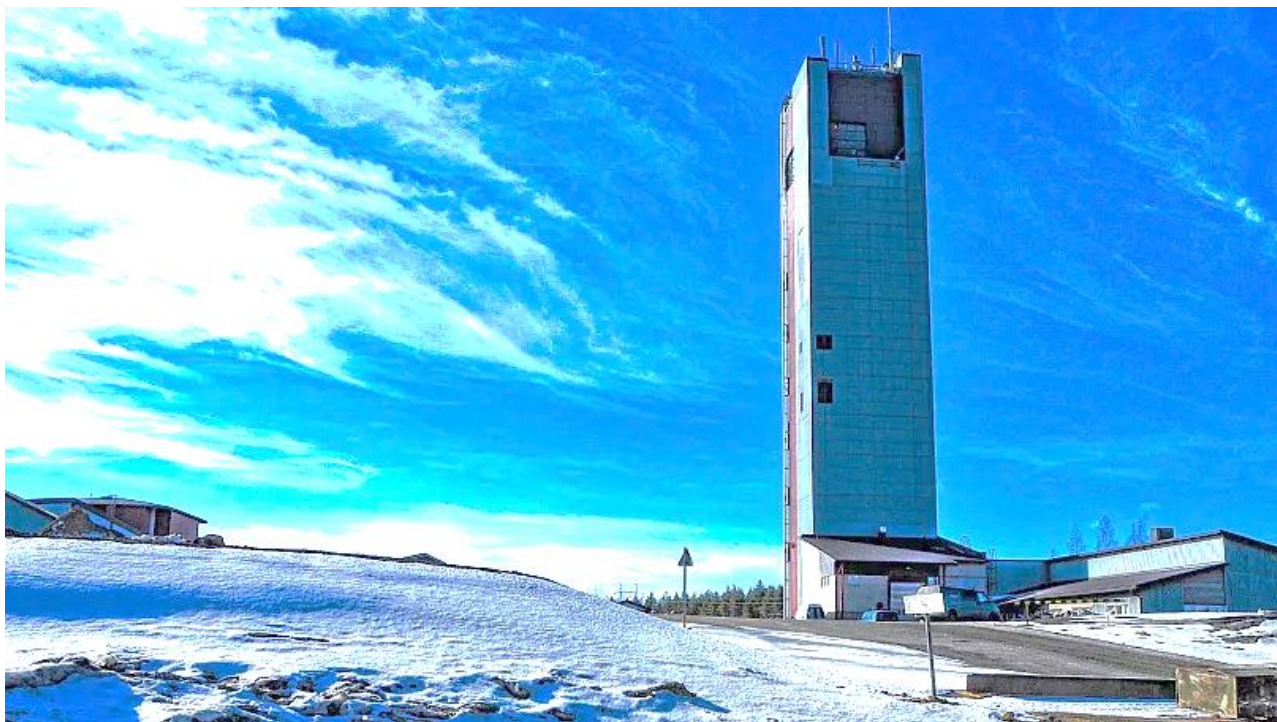
Рис. 3.6. Головний ствол мідно-цинкової шахти Пюхярві у Фінляндії є місцем розміщення першої комерційної системи зберігання енергії під дією сили тяжіння. (Фото: Gravitricity)
