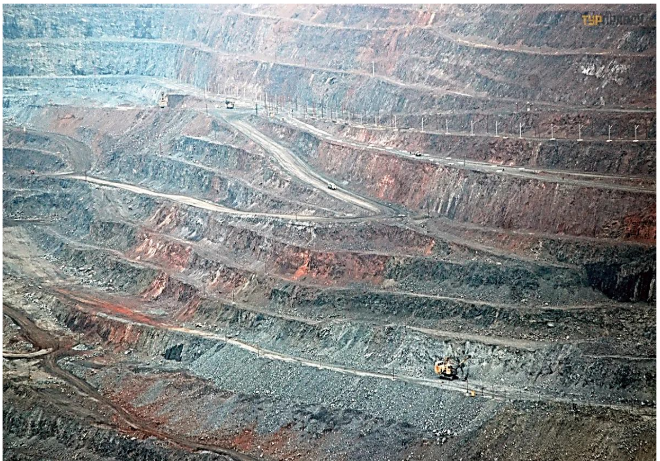
Рис. 3.3. Капітальний борт кар'єру «ПівдГЗК» (Джерело: https://www.turpravda.com/places/ua/krivoy_rog/ZHelezorudnyj_karer_JUGOK-s5519/# [39])
