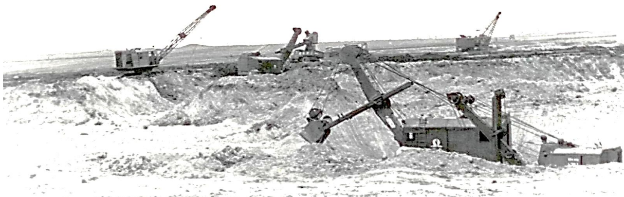
Рис. 3.4. Драглайни та мехлопати СЕ-3 на розкривних роботах кар'єру ПівдГЗК (Джерело: https://kryvyi-rih.name/ru/eternal-1820-istoriya-karera-yugok-v-krivom-roge [40])
