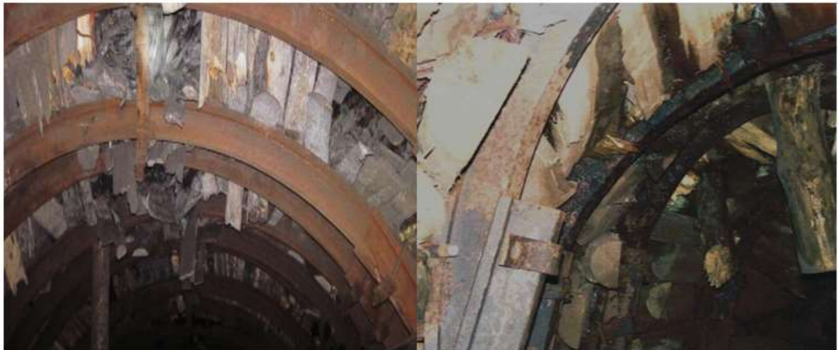
Рис. 2.3. Наслідки проявів гірничого тиску в умовах шахти «Ювілейна» на гор. 1340 м.
