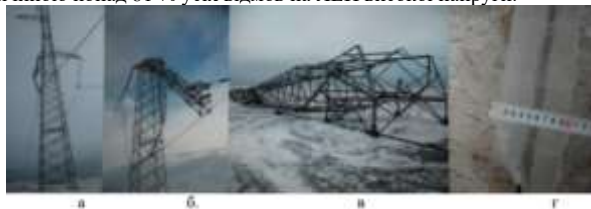
Рис. 1 – Приклад аварій, спричинених відкладенням ожеледі: а – руйнування траверси фази С; б – руйнування проміжної ПЛ 330 кВ; в – муфта ожеледі на проводі
