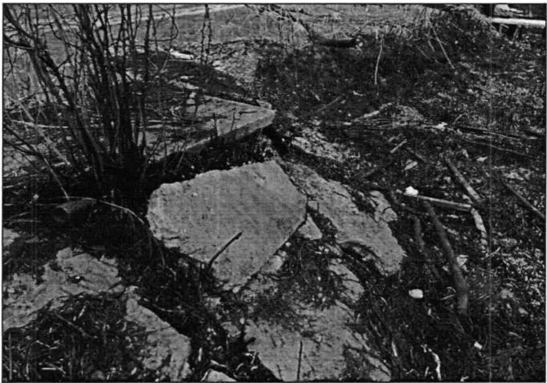
Фото 1.2. Стан фіксуючих берегових конструкцій.
