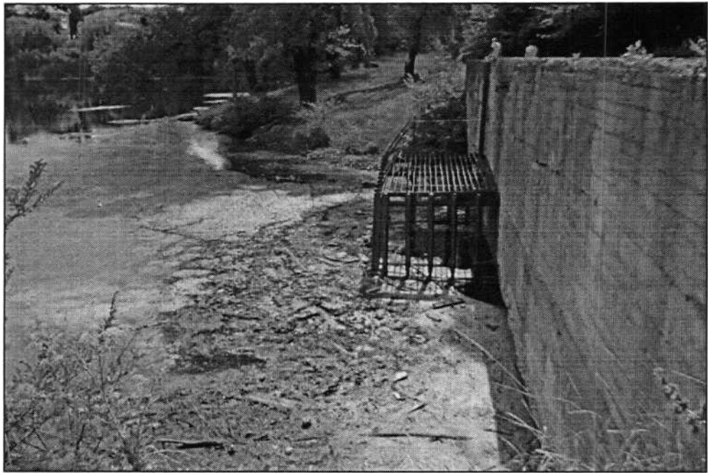
Фото 1.26. Стан русла та гідравлічна споруда дериваційного тунелю №2.
