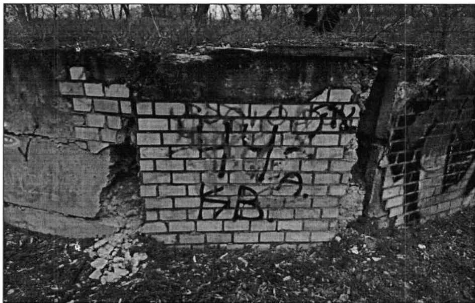
Фото 1.5. Стан гідротехнічних споруд
