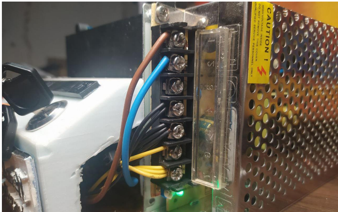
Рисунок 3.26 — Встановлення блоку живлення
