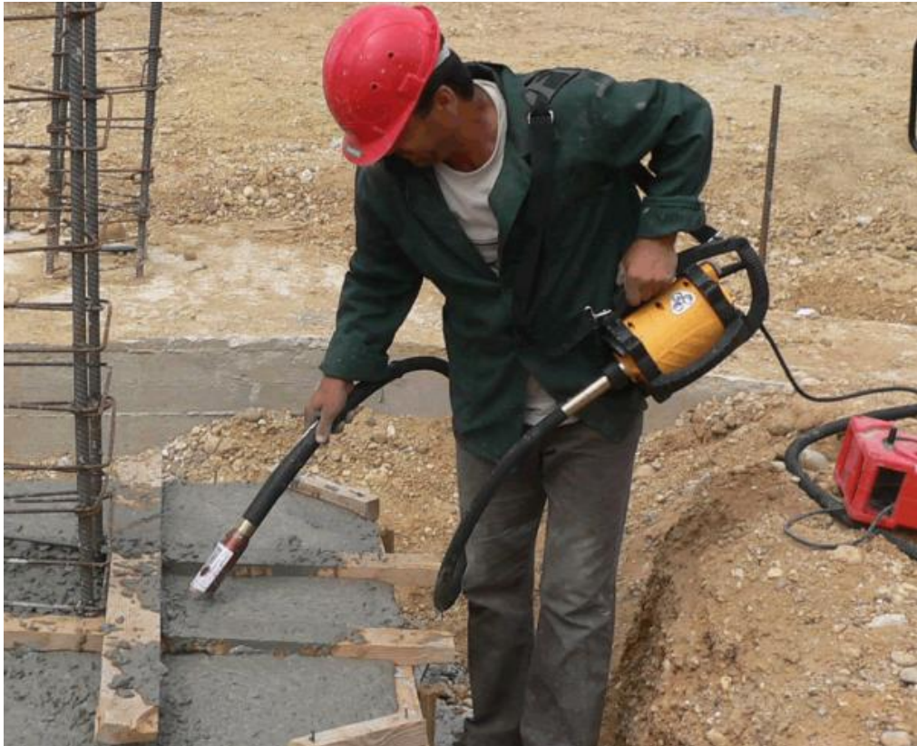
Рис.4.2. Вібрування бетонної суміші
