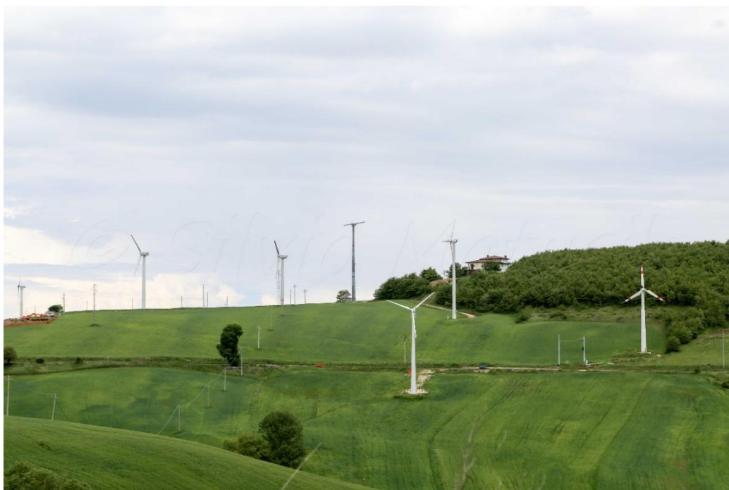
Рисунок 1.1 Вітрогенератор Hummer H25.0-100KW / 100 кВт / Contrada Malepasso, Італія
