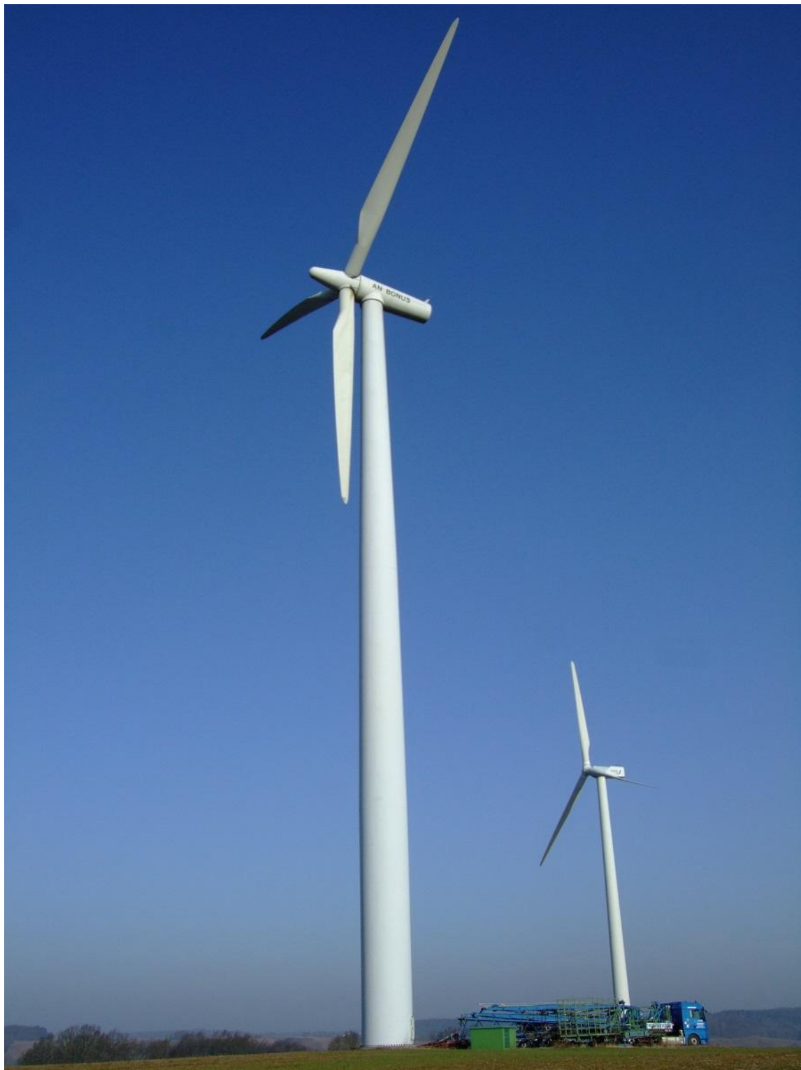
Рисунок 1.3 Вітрогенератор AN Bonus 1000/54 1000 кВт / Німеччинна
