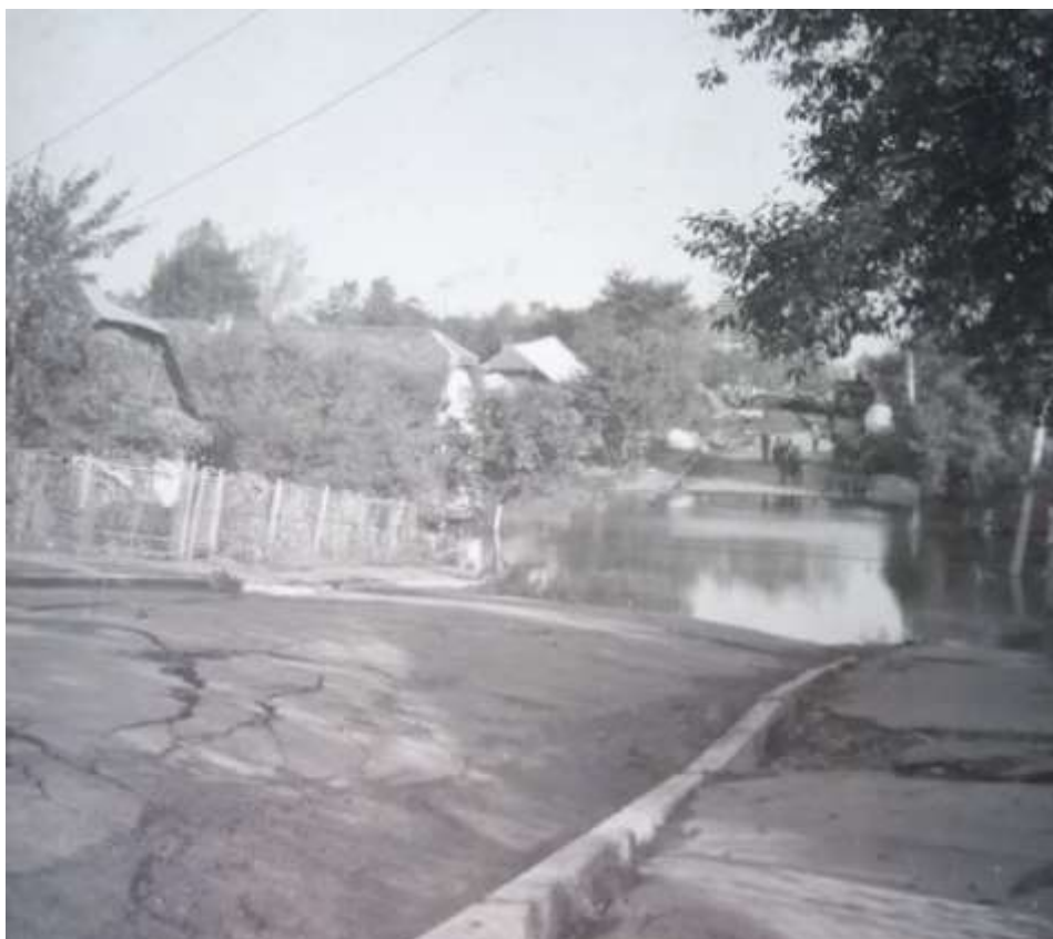
Рис. 1.1. Перше провалля земної поверхні в місті Калуш, яке утворилося влітку 1987 року на колишній вулиці Пархоменка (нині — Вітовського) через просідання землі над шахтними пустотами рудника "Калуш"
