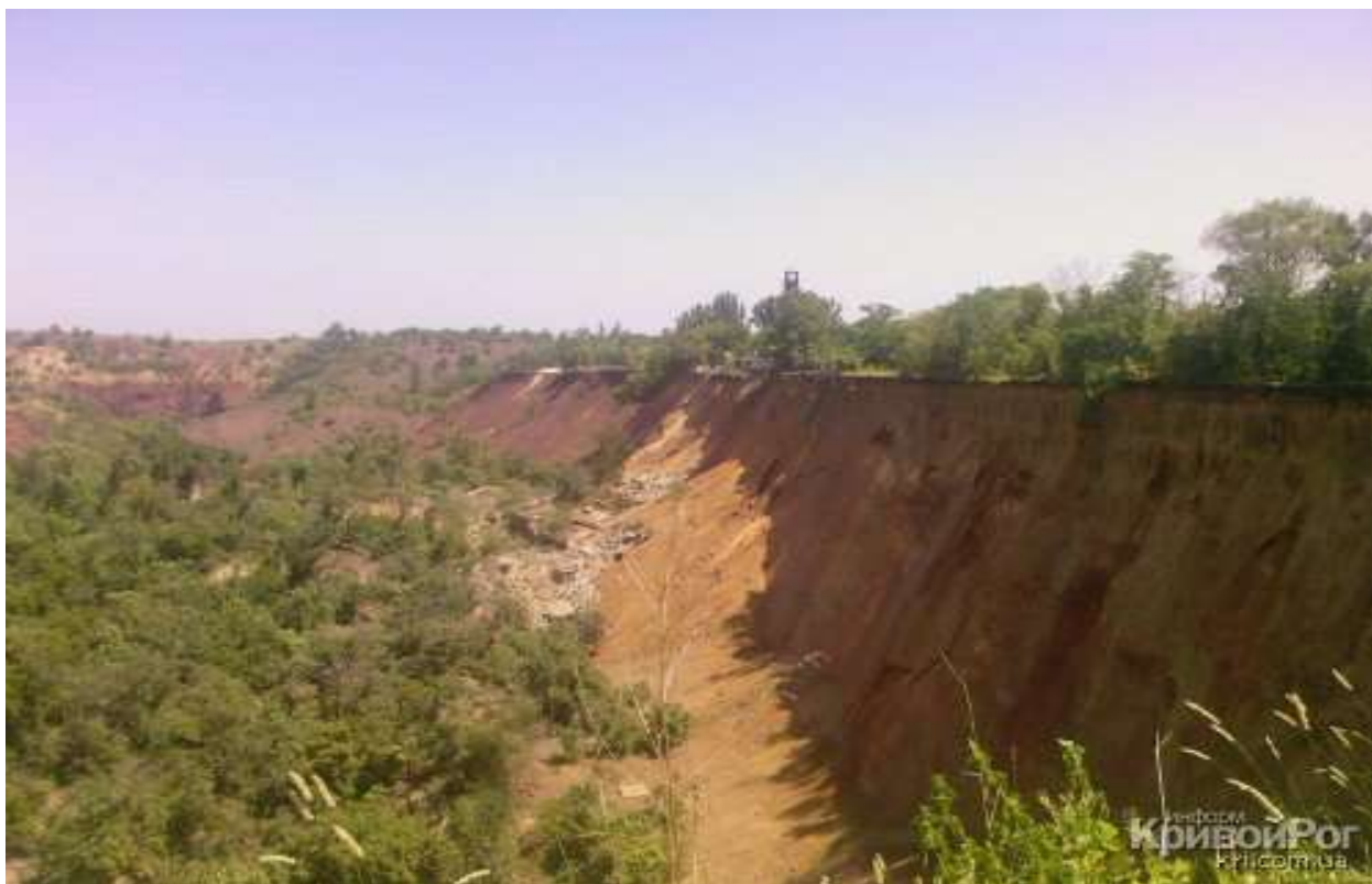
Рис. 1.2. Провал денної поверхні в зоні гірничого відводу шахти ім. Орджонікідзе (нині шахта ім. Колачевського)
