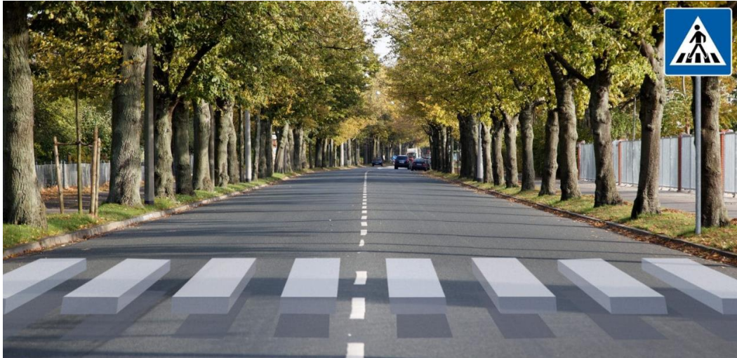
Рис.1.4. Об'ємна розмітка пішохідного переходу
