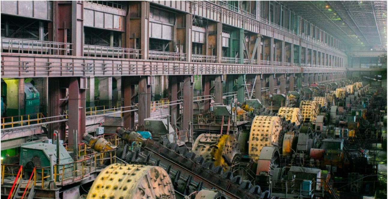
Рис. 1.1. Фабрика збагачення (загальний вигляд)
