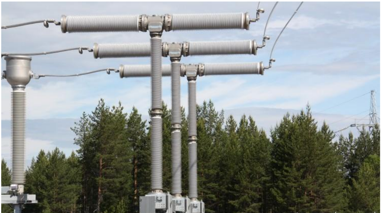
Рисунок 1.2 – Роз'єднуючий вимикач марки Siemens
