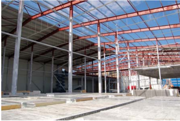
Рис. 1. Монтаж покрівельного покриття й стін панелями "Сендвич" на сталевих конструкціях
