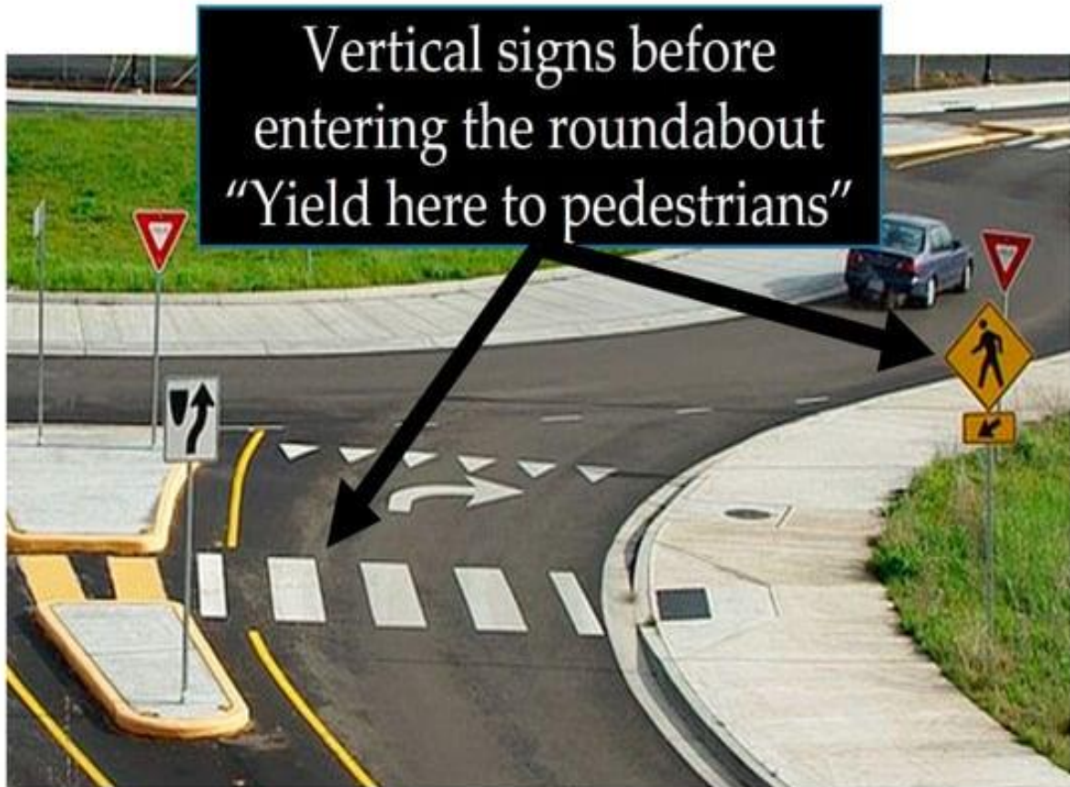
Рисунок 5. В'їзд на кільцеву розв'язку та розмітка для пішоходів.
