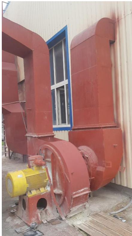
Рисунок 1.4 – Вентилятор ВД-167-37-10 (виконання 3)
