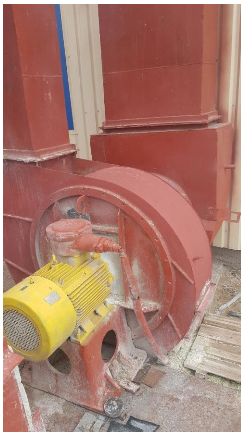
Рисунок 1.8 – Монтаж приводного двигуна вентилятора ВД-167-37-10
