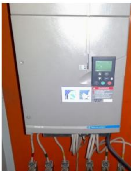
Рисунок 2.14 - Частотний перетворювач Altivar 38
