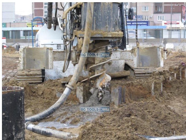
Рисунок 8.3 – Кінець бетонування палі
