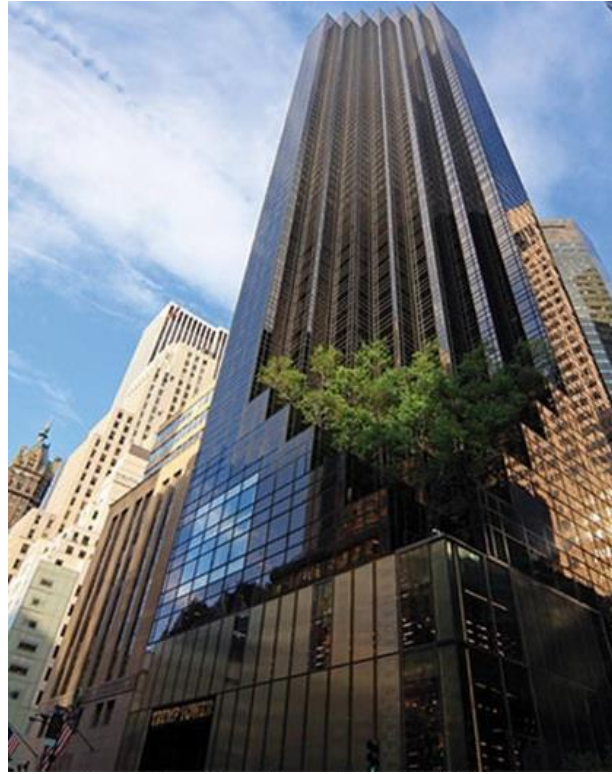
Малюнок 1.3 - Будівля « Trump Tower », Нью-Йорк, США
