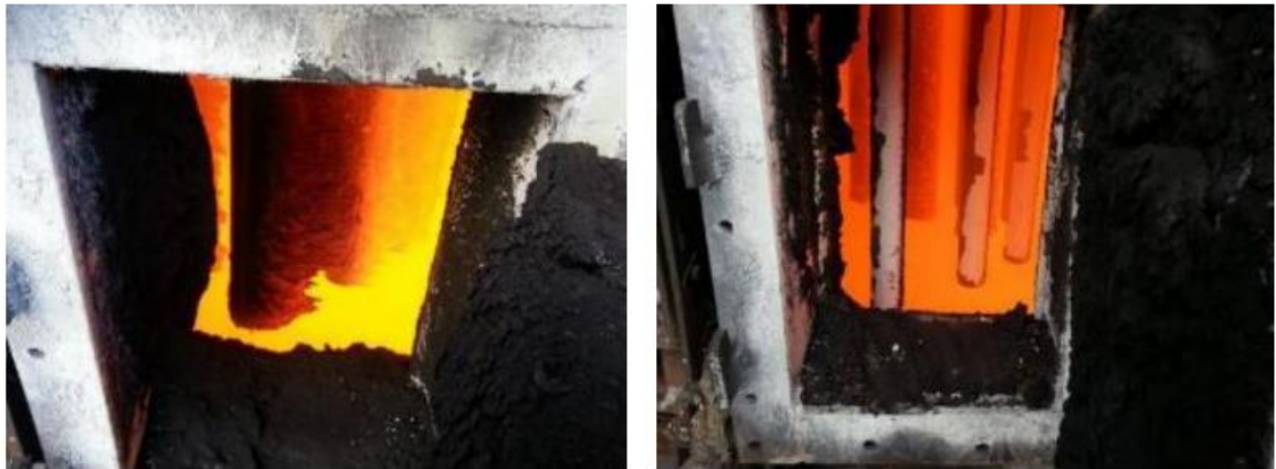
Рис.1.8 Налипання сполук сірки, що догорає на поверхні нагріву
