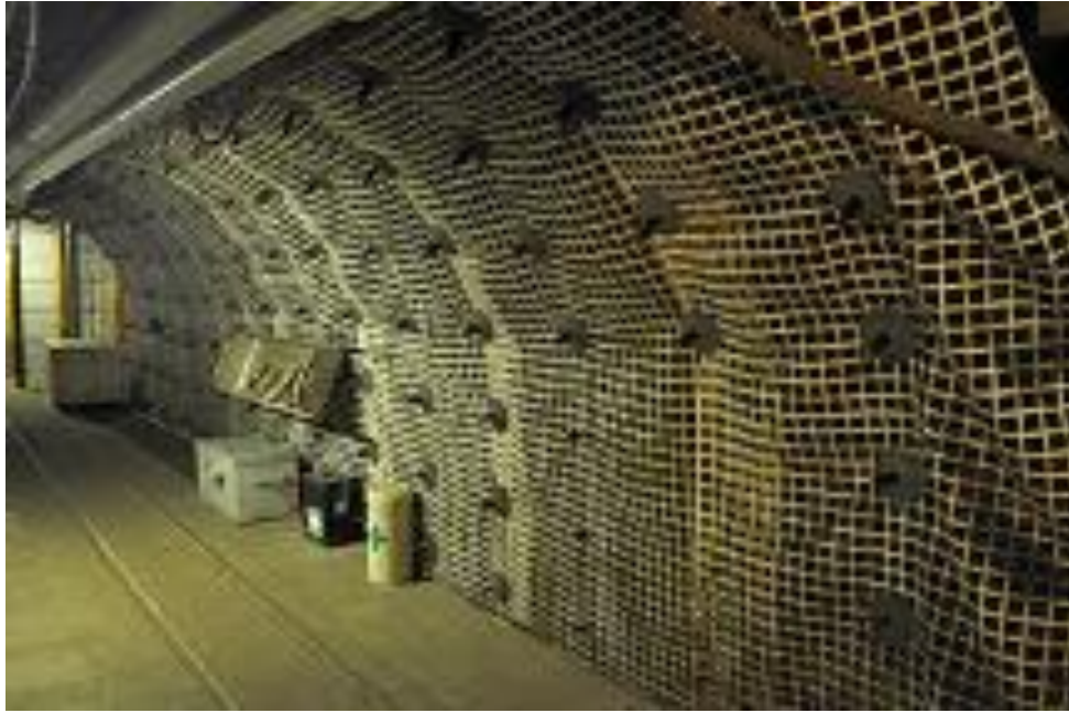
Рисунок 3.1 – Гірничі виробки, закріплені анкерами та натягнута сталеву дротяною сіткою
