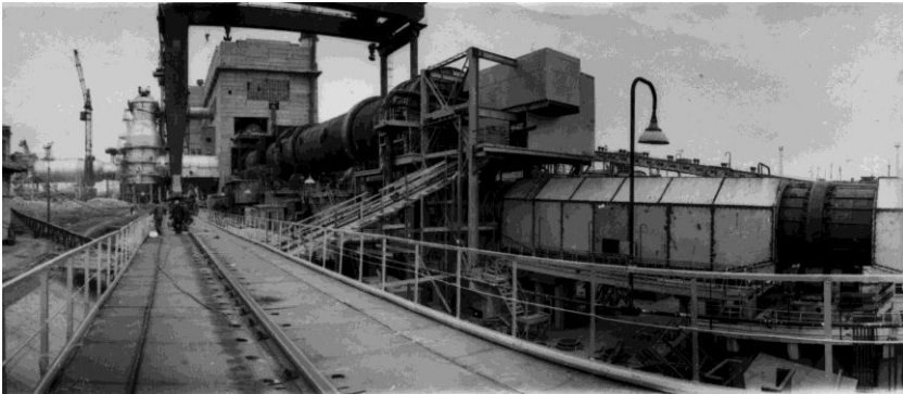
Рис. 7.6. Загальний вигляд установки ПівнГЗК
