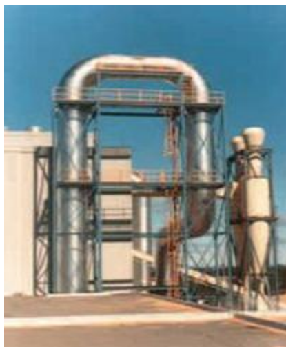
Рис. 2.6 – Пневматична труба-сушарка.
