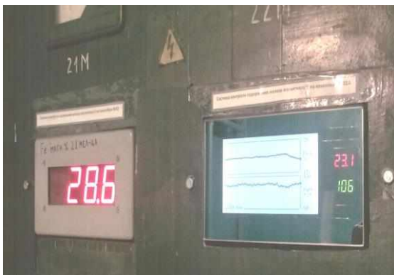
Рис. 6. Табло з графічною індикацією результатів безперервного контролю вмісту заліза магнітного та ваги гірничої маси на конвеєрі
