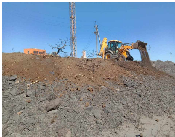
Рис. 7. Процес нанесення мулових осадків
