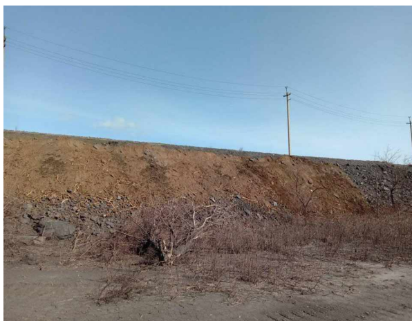
Рис. 6. Мулові осадки на зовнішній частині ярусу хвостосховища
