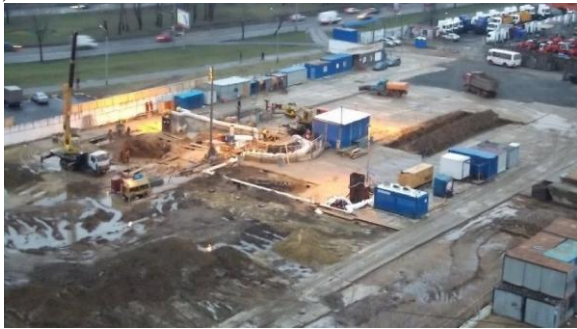
Рис. 3.1. Будівельний майданчик до початку виконання робіт
