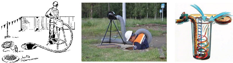
Рис. 8.12. Примусове провітрювання колодязя
