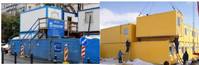
Рис. 3.4. Улаштування збірно-розбірних блок-контейнерів у два поверхи
