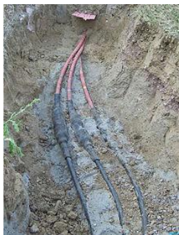
Рис. 6.3. Високовольтні кабелі в траншеї
