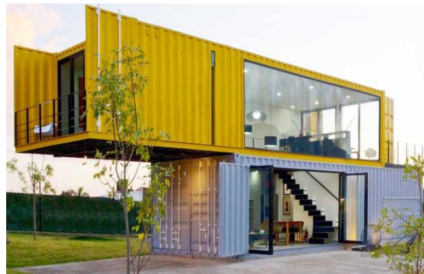
Рис.10. Приклад двоповерхового житлового будинку з різнокольорових морських контейнерів
