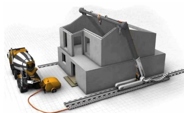
Рис.12. Технологія зведення двоповерхового житлового будинку методом 3D-друку
