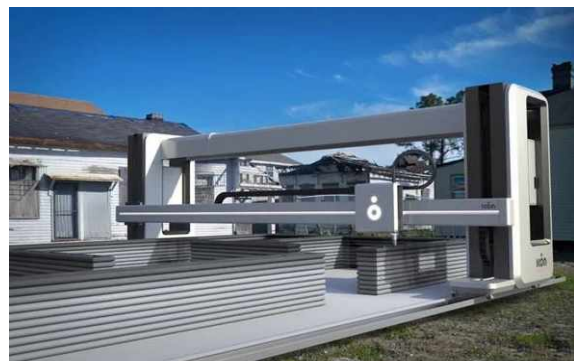
Рис.14. 3D-принтер Vulcan розробки компанії ICON
