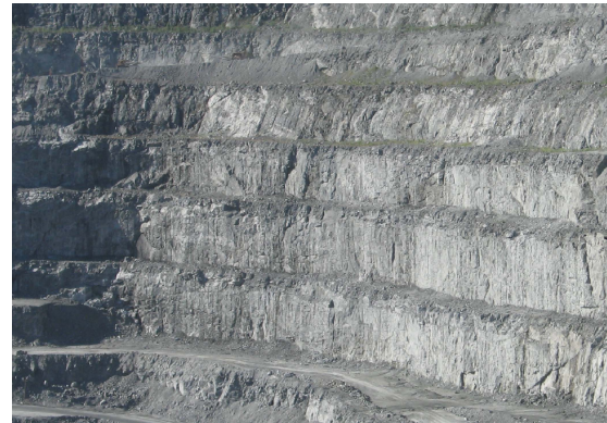
Рис. 2. Формирование борта карьера с использованием вертикальных уступов высотой 24 м (основной карьер ОАО "Ковдорский ГОК")
