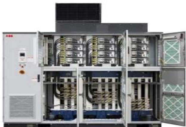
Рисунок 5 - Частотно-регульований привід типу ВПЧ-6-1000 та його характеристики
