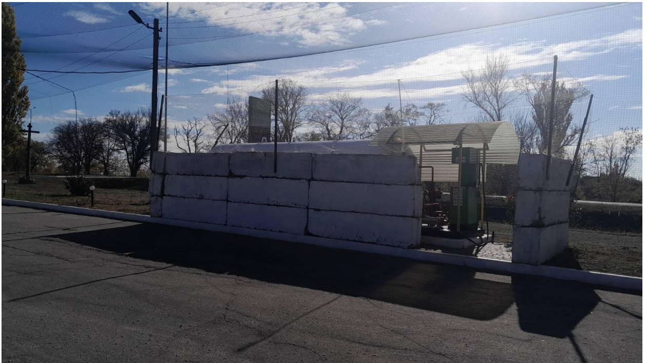
Рис. 1.5 – Зображення технологічного вузлу на АЗС із захистом від небезпек з повітря (антидроновна сітка).
