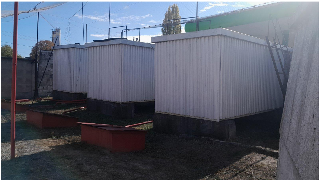
Рис. 1.5 – Зображення технологічного вузлу на АЗС із захистом від небезпек з повітря (антидроновна сітка).
