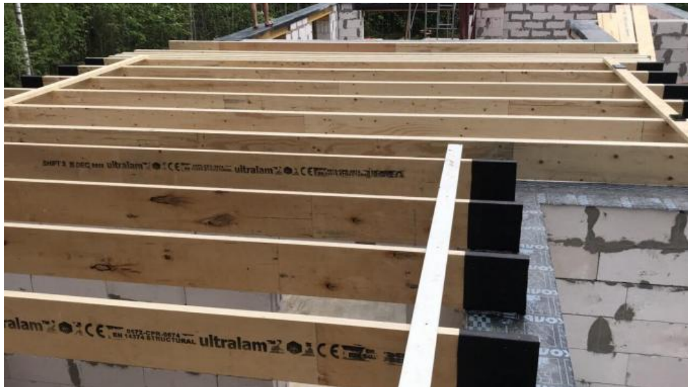
Рисунок 1 – Балки з LVL при влаштуванні міжповерхового перекриття
