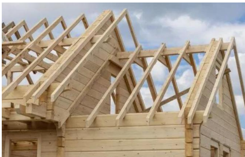
Рисунок 2 – Балки з LVL при влаштуванні кроквяної системи
