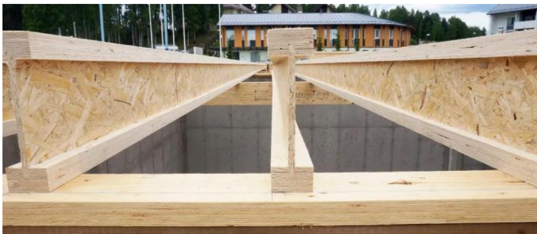
Рисунок 5 – Конструкція тонкостінних дерев'яних балок зі стінкою із ОСП та поясами із LVL
