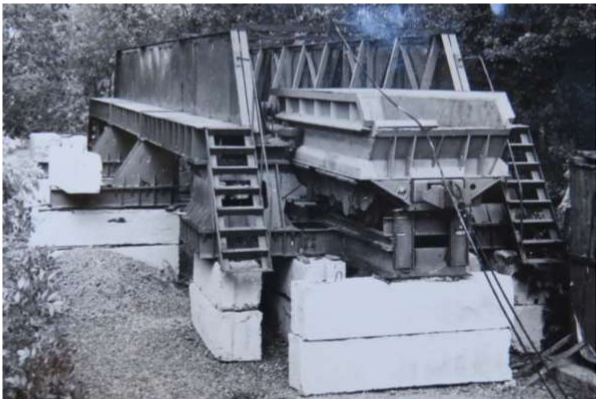
Рисунок 4.3 – Комплекс локомотивної відкатки з безупинним завантаженням і розвантаженням рухомого складу: а – потяг у складі саморозвантажних вагонеток; б – розвантажувальний пристрій
