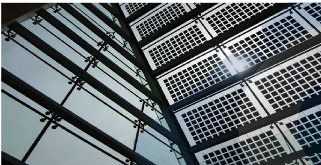
Рисунок 4.5 - Варіант фасадного використання двосторонніх сонячних панелей
