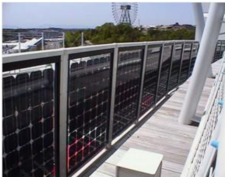
Рисунок 4.4 - Використання двосторонніх сонячних панелей в якості балконного огородження
