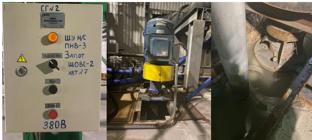
Рисунок 2.1 - Дренажна система згущувача та принцип її керування
