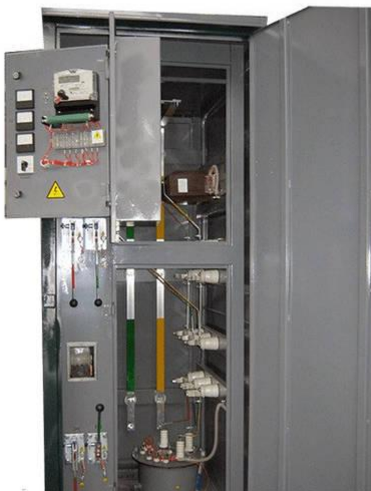
Рисунок 1.3 Комплектний розподільчий пристрій КРУ-6
