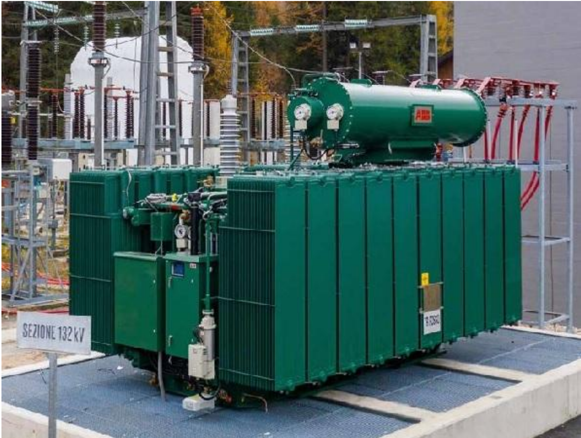
Рисунок 2.2. Загальний вигляд трансформатору АВВ ТХpert™ 10 МВА, 36/6 кВ
