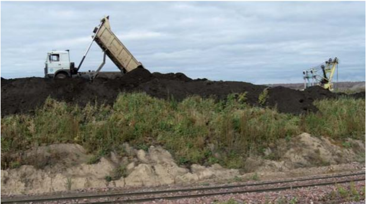
Рисунок 6 - Формування бурта висотою 6-8 м вздовж залізничної колії
