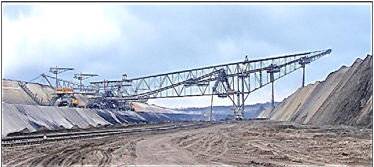
Рис. 2.9. Конвеєрний міст розкривних порід у кар'єрі Райхвальде (ковшовий ланцюговий екскаватор у Високий зріз, попереднє перекидання та точки 1 і 2 активні) [95]
