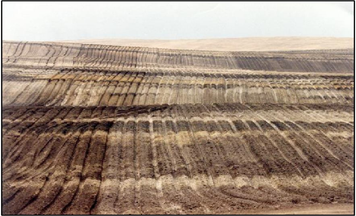
Рис 2.13. Вирівняний відвал АФВ з хвилястою поверхнею [98]
