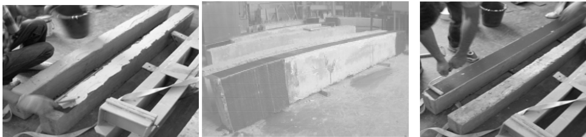
Рис. 2. Приклеювання елементів підсилення (1 етап)
