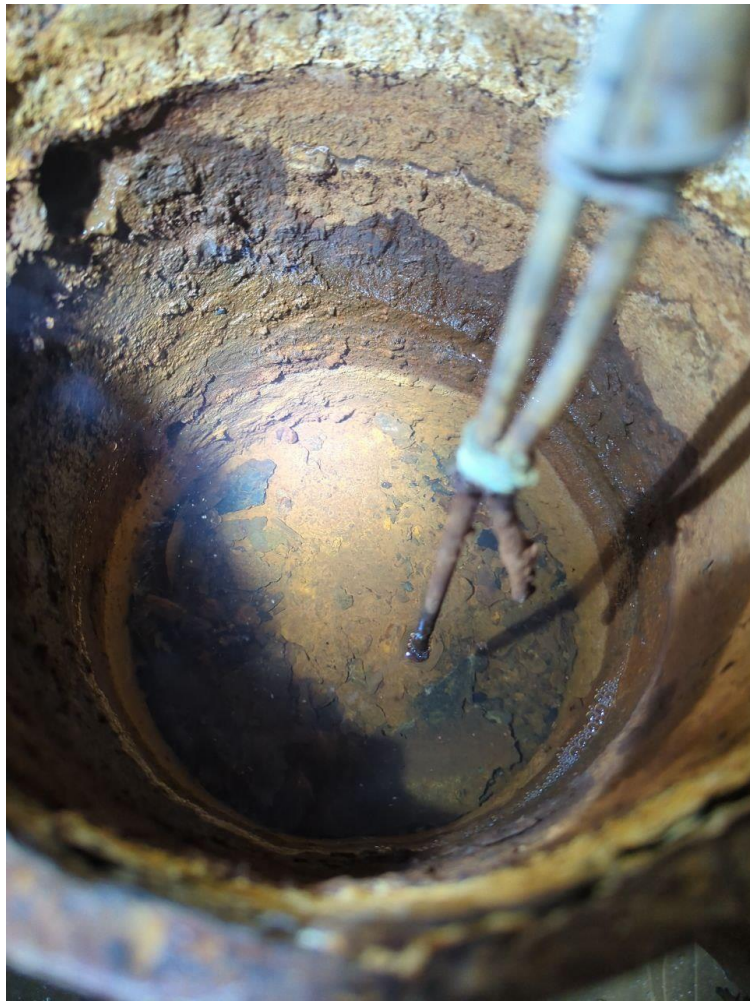
Рисунок 1.8 - Розширювач з електродом
