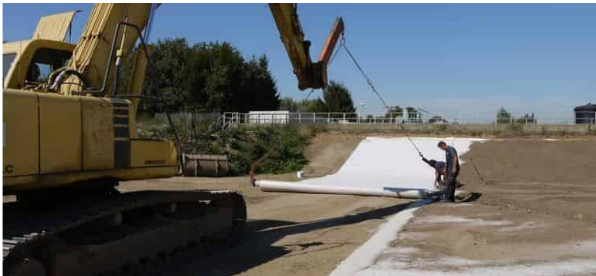
Рис. 3.5. Процес укладання бентонітових матів
