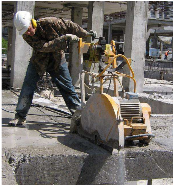
Малюнок 4 - Розпил плит за допомогою алмазної різання
