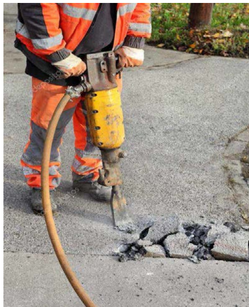
Малюнок 2 - Ручний пневматичний молоток для асфальтобетону
