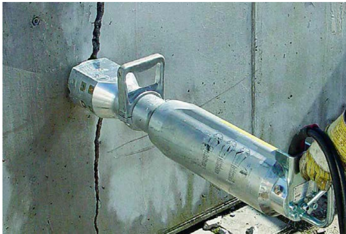
Малюнок 3 - Руйнування виробу з допомогою гідроклінового розколювач
