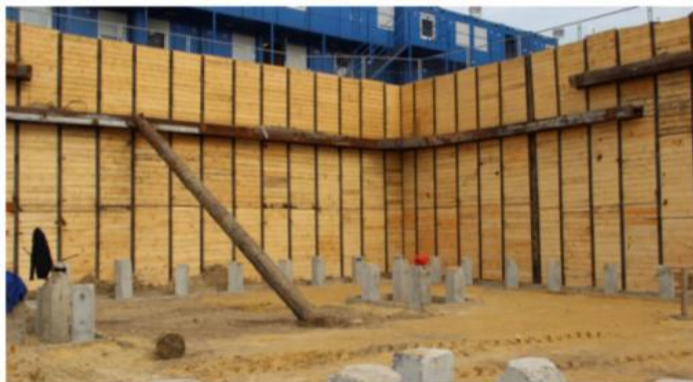
Рисунок 3 – Огородження котловану із сталевих стійок з дерев'яною дошкою.
