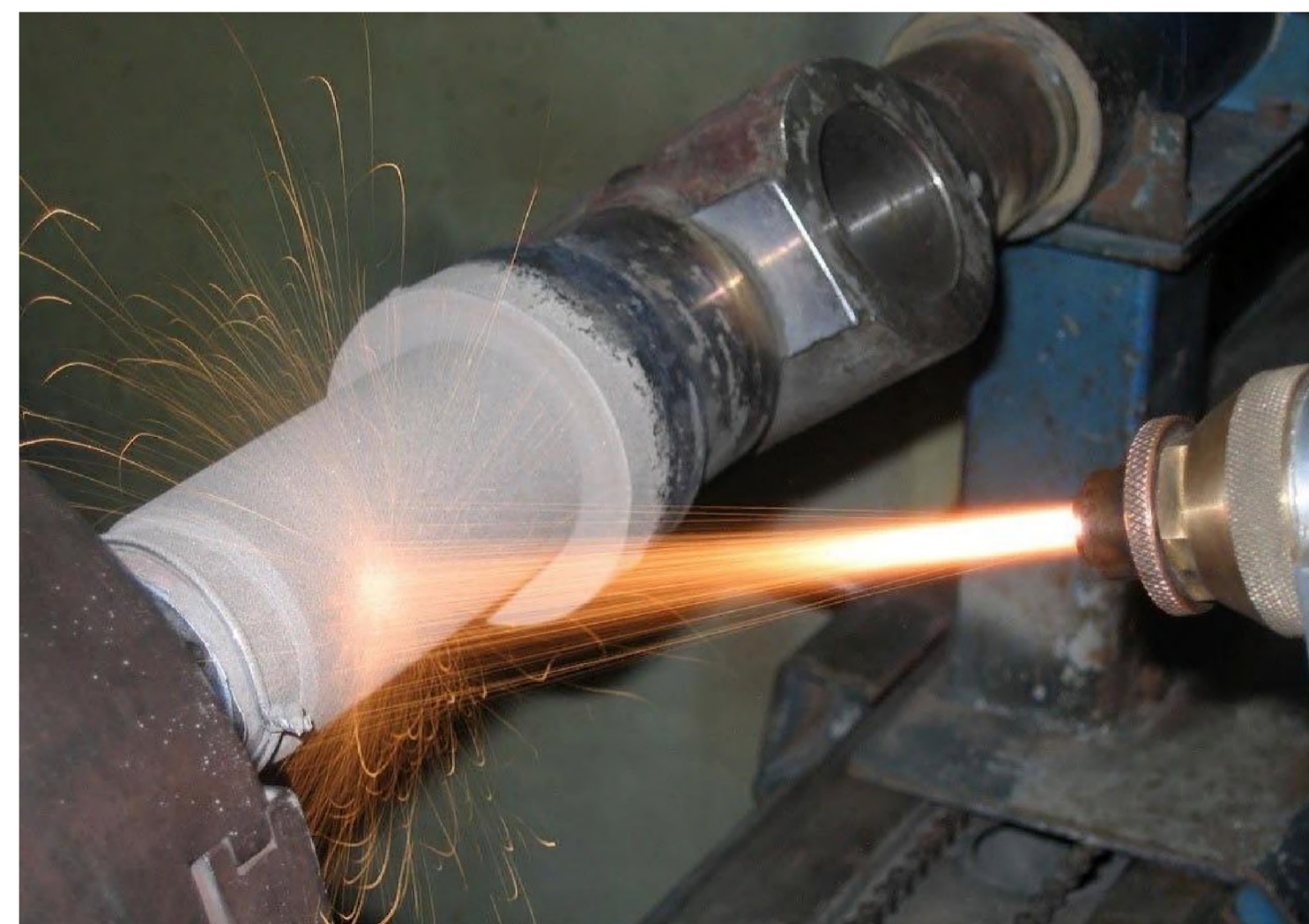
Процес газотермічного напилювання
