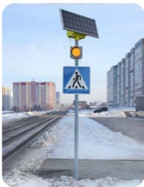
Рисунок 1.6 – Зовнішній вигляд та будова світлофору «LGM»
