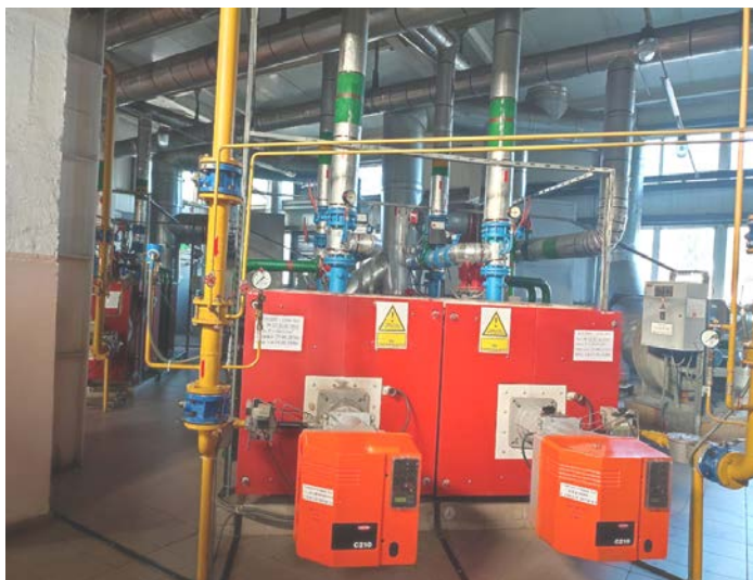
Рис. 4. Встановлення водогрійних котлів Viessmann Vitoplex 200 тип Sx2A
