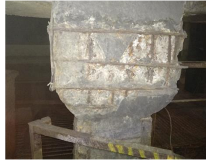
Рис. 4. Найбільш характерні пошкодження залізобетонний стійок
