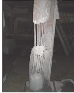
Рис. 3. Найбільш характерні пошкодження трубобетонних стійок
