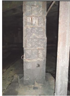
Рис. 4. Найбільш характерні пошкодження залізобетонний стійок
