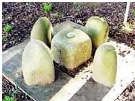
Рис. 6. Варіант закріплення геодезичного пункту
