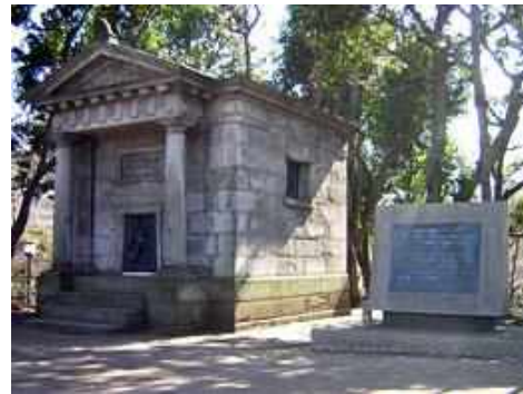
Рис. 4. Японський вихідний репер нівелювання (1-1 Нагата-чо, Чиода-ку, Токіо)
