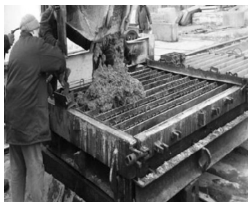
Рис. 3. Формування дослідних зразків балок
