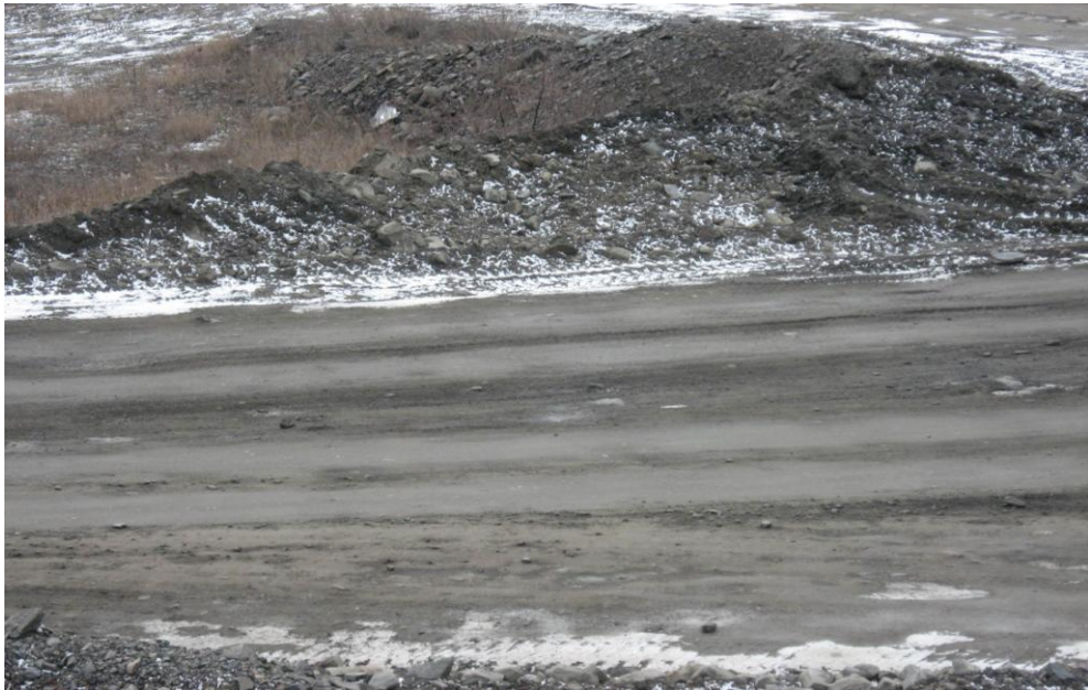
Рисунок 2.15 Закріплена ділянка автодороги
