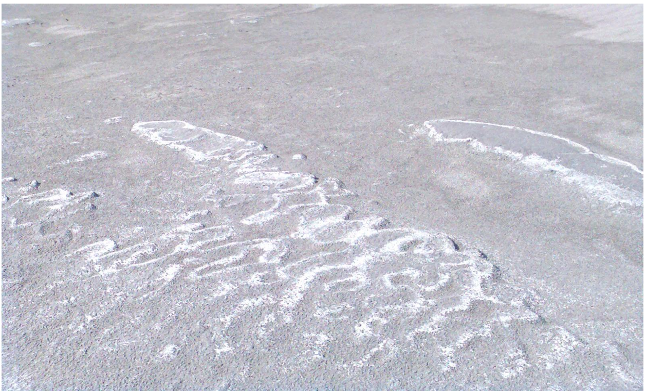
Рисунок 3.4 Поверхня хвостосховища, закріпленого бішофітом: світлі ділянки - сіль, що виступила
