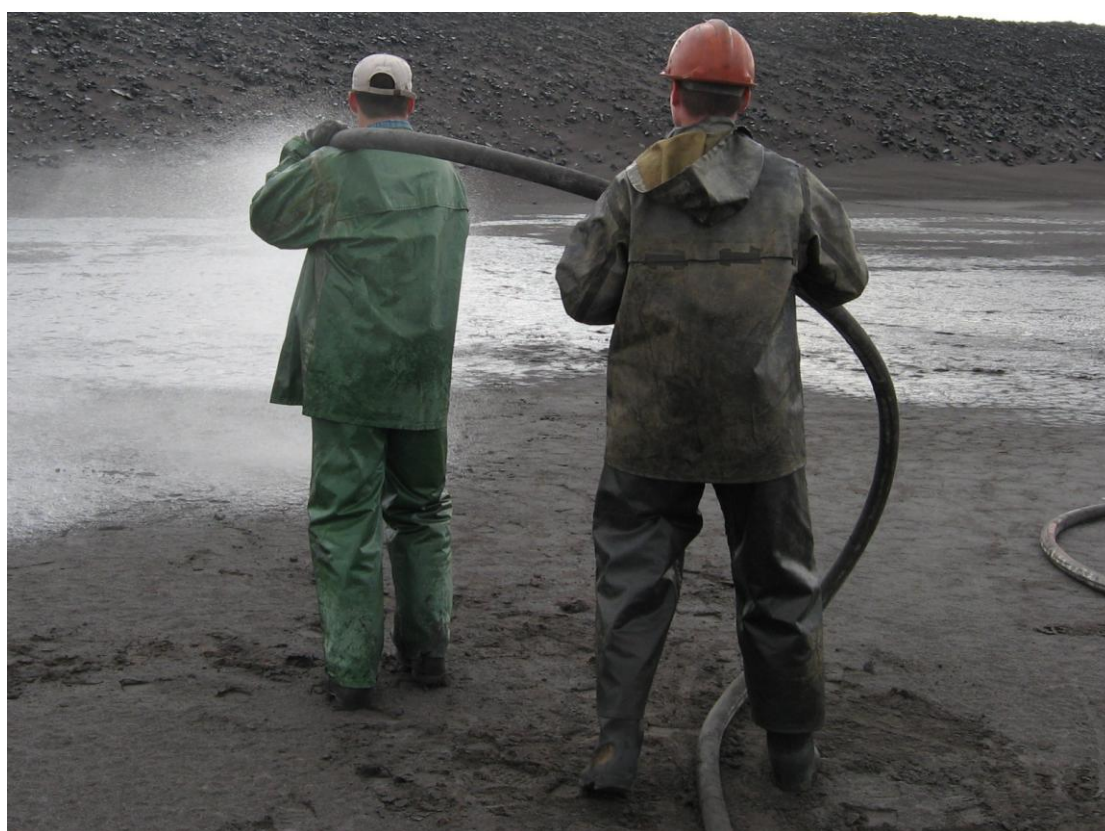
Рисунок 4.7. Нанесення розчину на поверхню хвостосховища за допомогою пожежних рукавів
