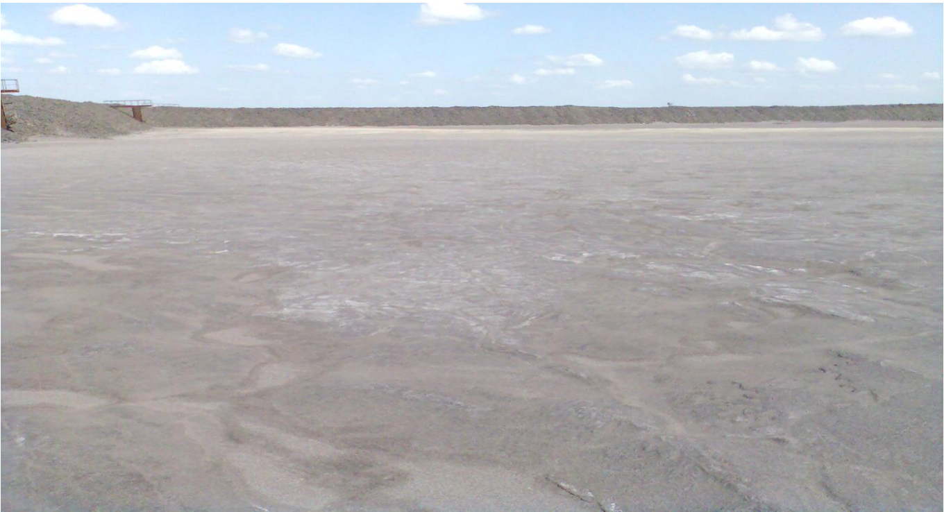
Рисунок 3.3 Загальний вигляд хвостосховища, закріпленого бішофітом
