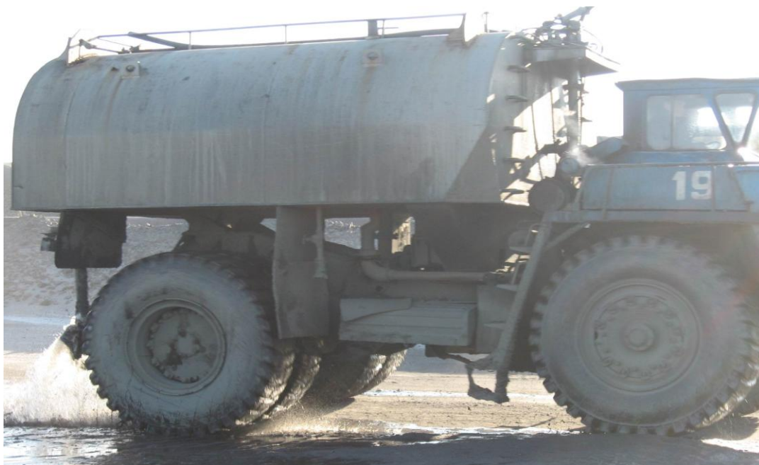
Рисунок 4.5 Нанесення бішофіту на поверхню автодороги
