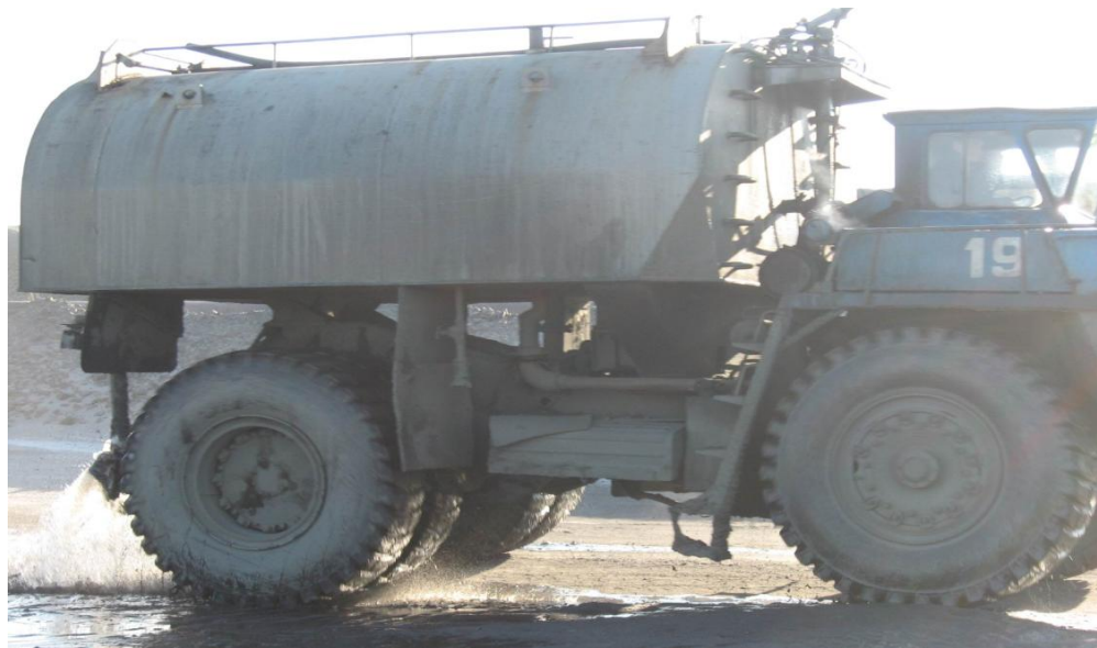
Рисунок 2.14 Нанесення бішофіту на закріплювану поверхню
