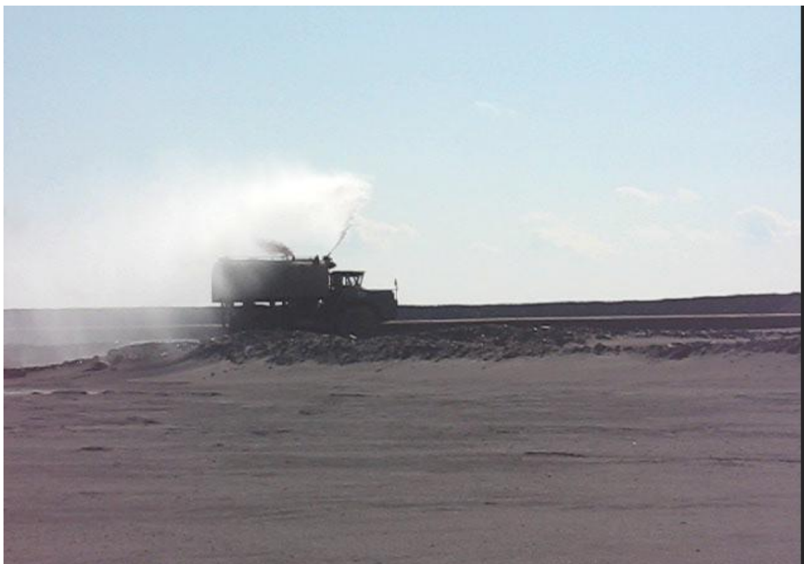
Рисунок 4.6 Нанесення розчину на поверхню хвостосховища
