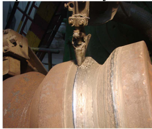
Рис. 4. Процес наплавлення валка
