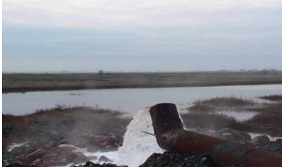
Рис. 1. Сброс шахтных вод в пруд-отстойник в балке Свистунова
